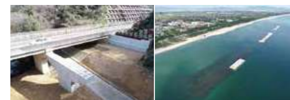
左) 寺谷川砂防災害復旧工事(1工区)(25年災42号) 右) 境港外港地区防波堤(2)工事(その2)
