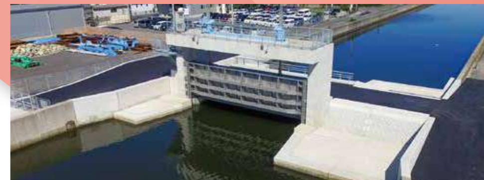
法勝寺川四ヶ村堰 改築工事
