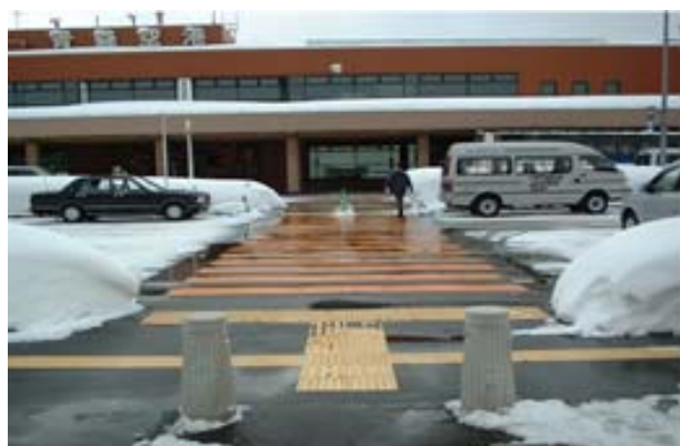
青森空港:歩道へのロードヒーティング
