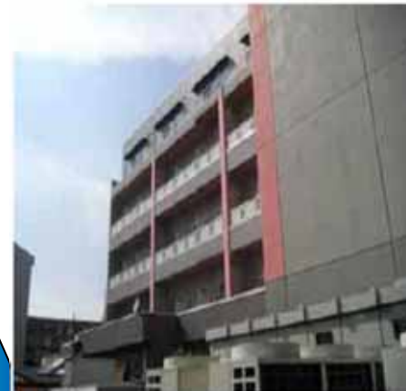
外壁を取りはらって窓とベランダを整備
